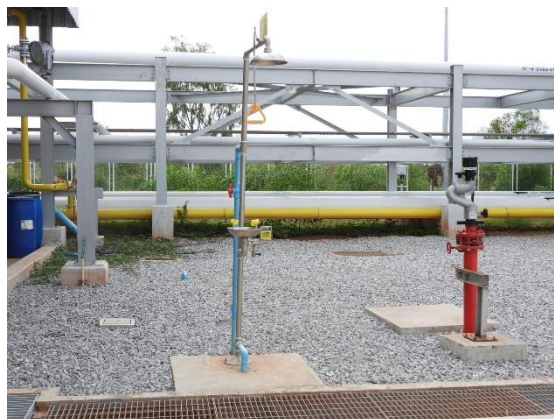
รูปที่ 2-18 จุดชำระล้างฉุกเฉิน (Emergency eye washer and shower)
