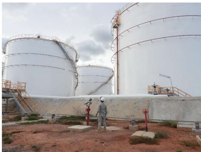
รูปที่ 2-19 คันคอนกรีตรอบถังน้ำมันภายในพื้นที่โครงการ
