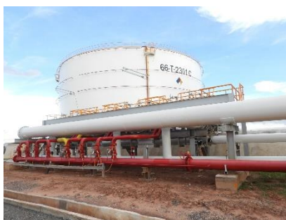
รูปที่ 2-20 ระบบป้องกันและระงับอัคคีภัยบริเวณถังน้ำมัน
