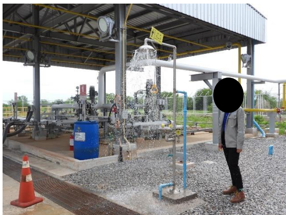
รูปที่ 2-18 จุดชำระล้างฉุกเฉิน (Emergency eye washer and shower)
